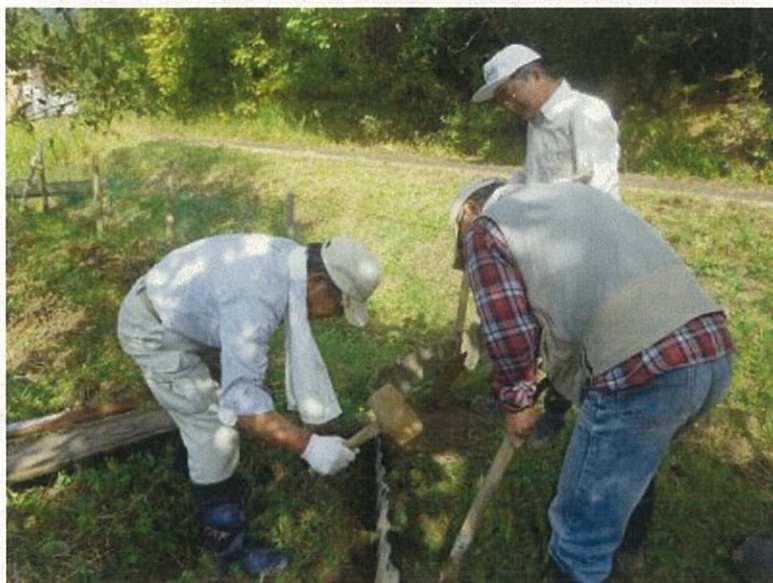
水路からの漏水を防止するため あぜ板を設置
