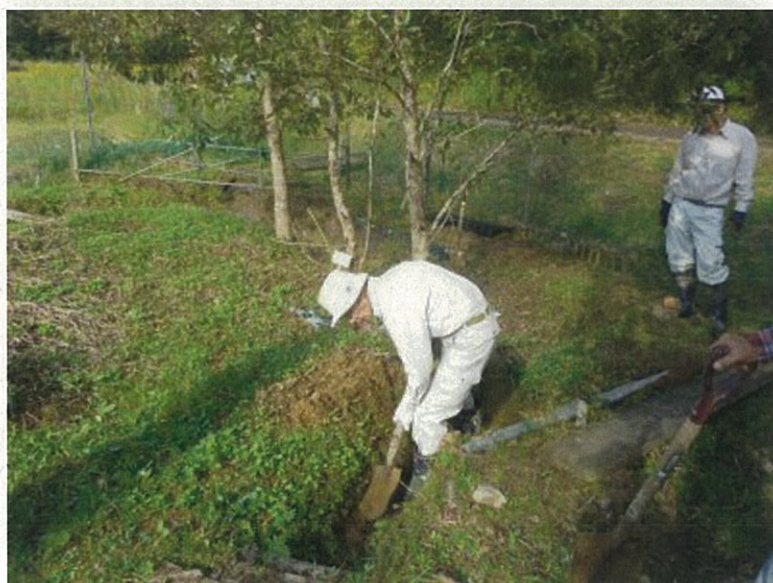
水路に堆積した土砂を除去
