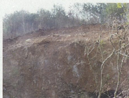
洞窟上部の崩壊
